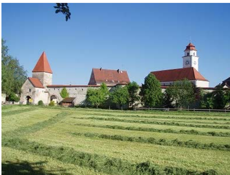
Ortsbefestigung mit nördlichem Torturm
